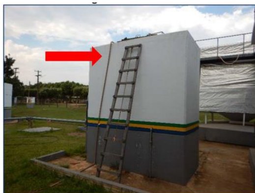
Figura 10. Visão geral da câmara de contato, com destaque para a tubulação de aplicação do agente desinfetante
