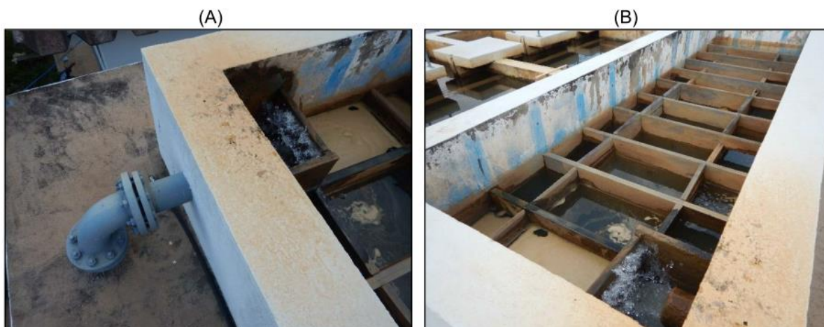
Figura 07. (A) Entrada da água bruta no floculador (B) Visão geral do floculador
