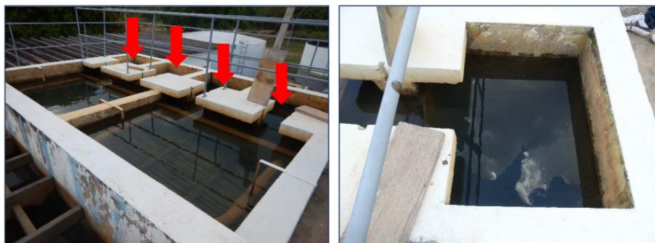
Figura 09. (A) Visão geral dos filtros (B) Água transbordada do decantador chegando em um dos filtros
