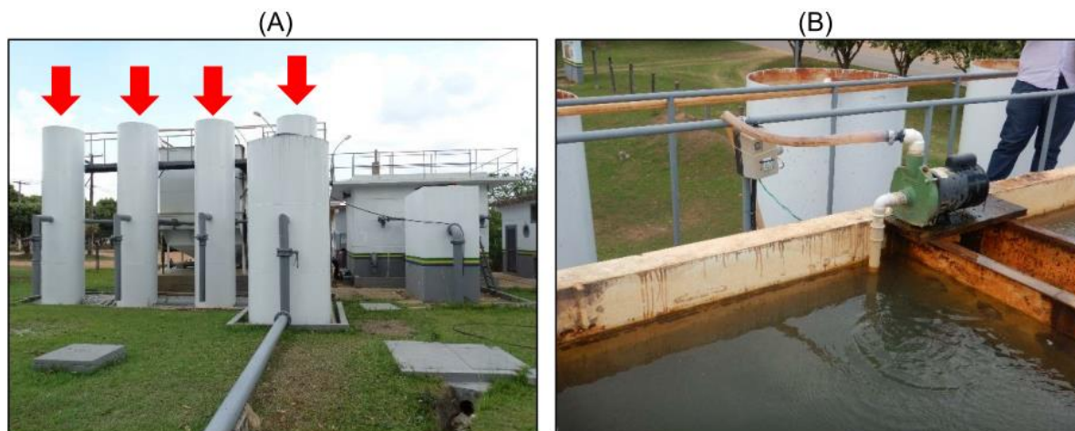
Figura 13. (A) Visão geral dos filtros (B) Bomba utilizada na retrolavagem dos filtros
