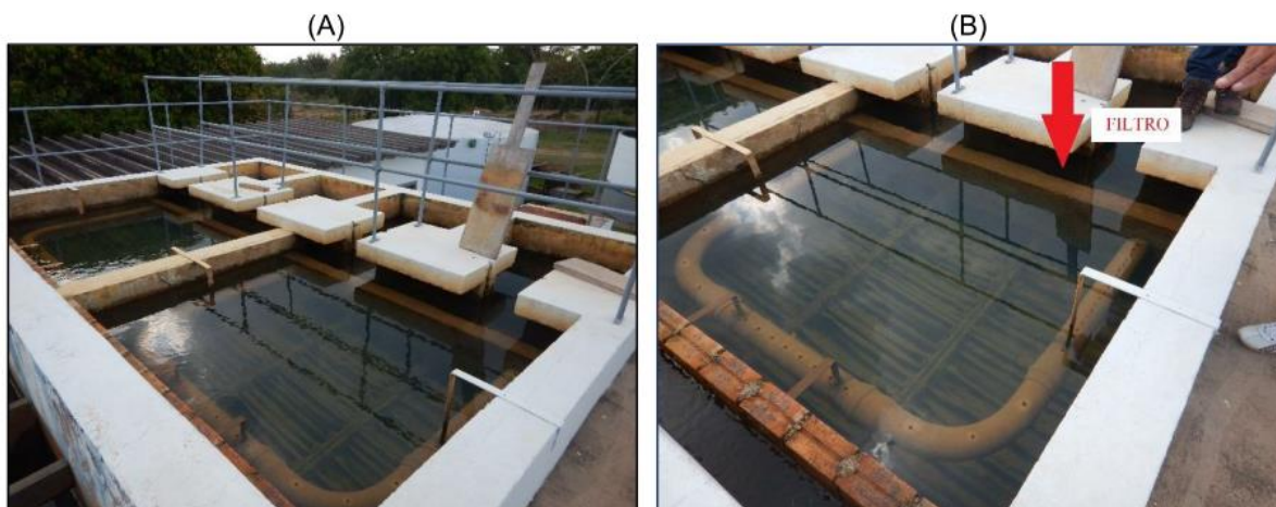
Figura 08. (A) Visão geral do decantador (B) Transbordamento do dispositivo de decantação
