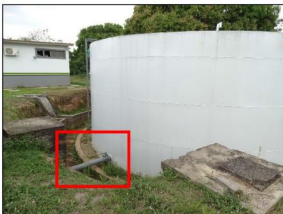
Figura 18. Tubulação que encaminha a água do reservatório de concreto ao reservatório metálico
