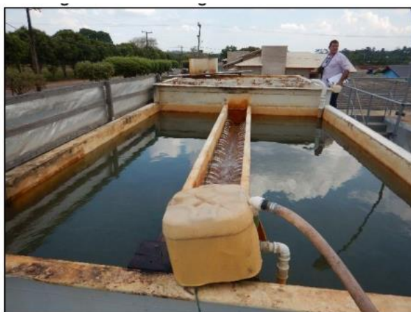
Figura 12. Visão geral do decantador
